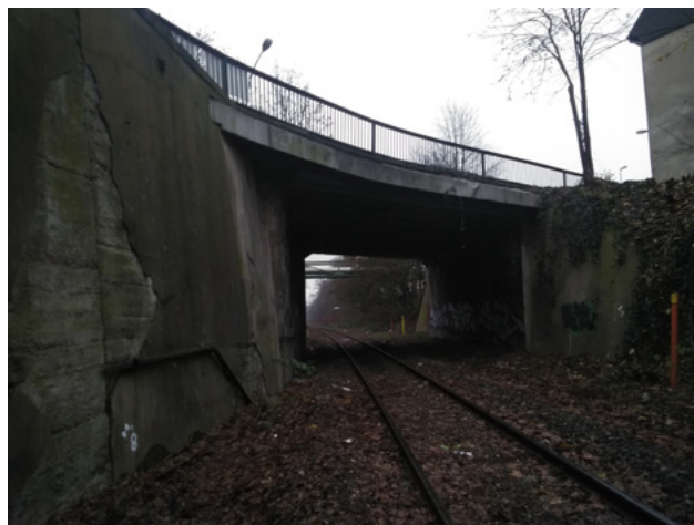
Abbildung 20: Foto Brücke Bielefelder Straße 117
